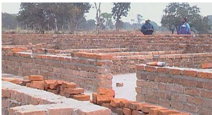
Luglio 2010 - Costruzione dei muri perimetrali ed interni
