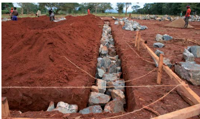
Giugno 2010 - Inizio lavori di scavo e getto delle fondazioni (2)
