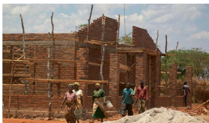
Ottobre 2010 - Completamento dei muri perimetrali esterni e dei divisori interni (2)
