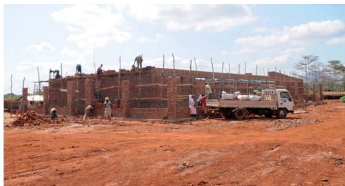
Ottobre 2010 - Completamento dei muri perimetrali esterni e dei divisori interni (1)
