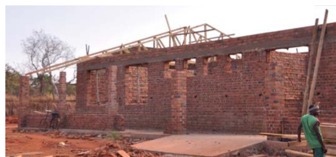
Ottobre 2010 - Posa in opera di capriate in legno per copertura
