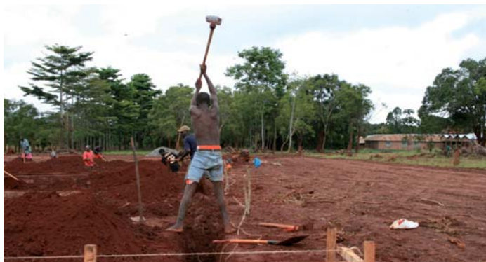
Giugno 2010 - Inizio lavori di scavo e getto delle fondazioni (1)
