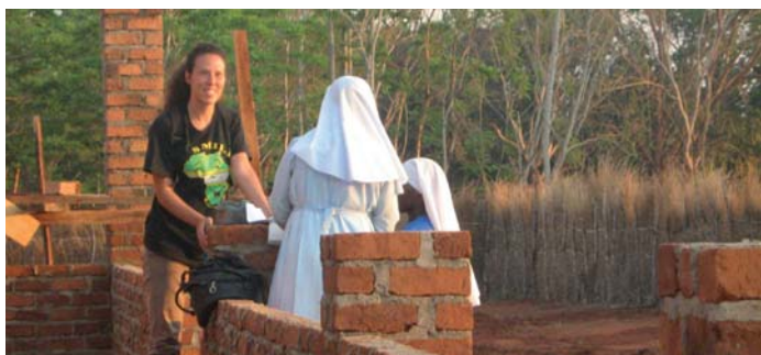
Settembre 2010 - Volontaria di Smile Africa che segue l'avanzamento del cantiere
