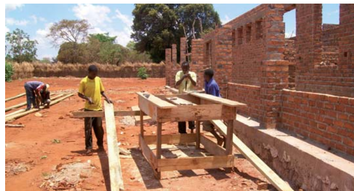
Ottobre 2010 - Inizio dei lavori di copertura con capriate in legno
