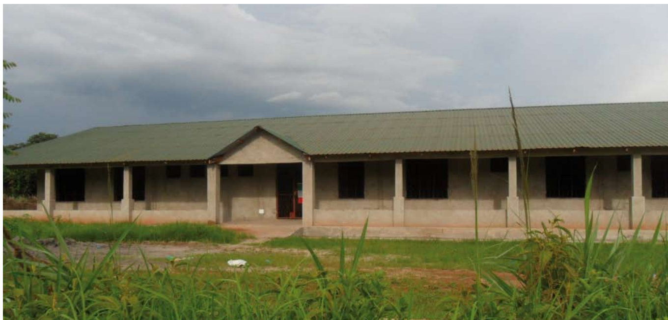
Foto: vista dell'Ospedale "Hope of Life" allo stato attuale. La struttura sarà inaugurata i primi di Settembre 2012, per poi iniziare con l'ampliamento.
